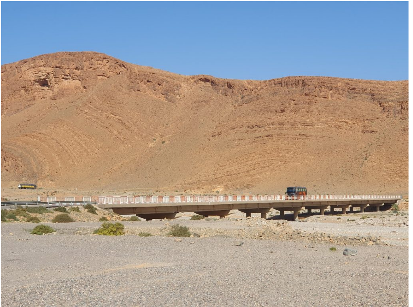
Brücke über trockenen Wadi
