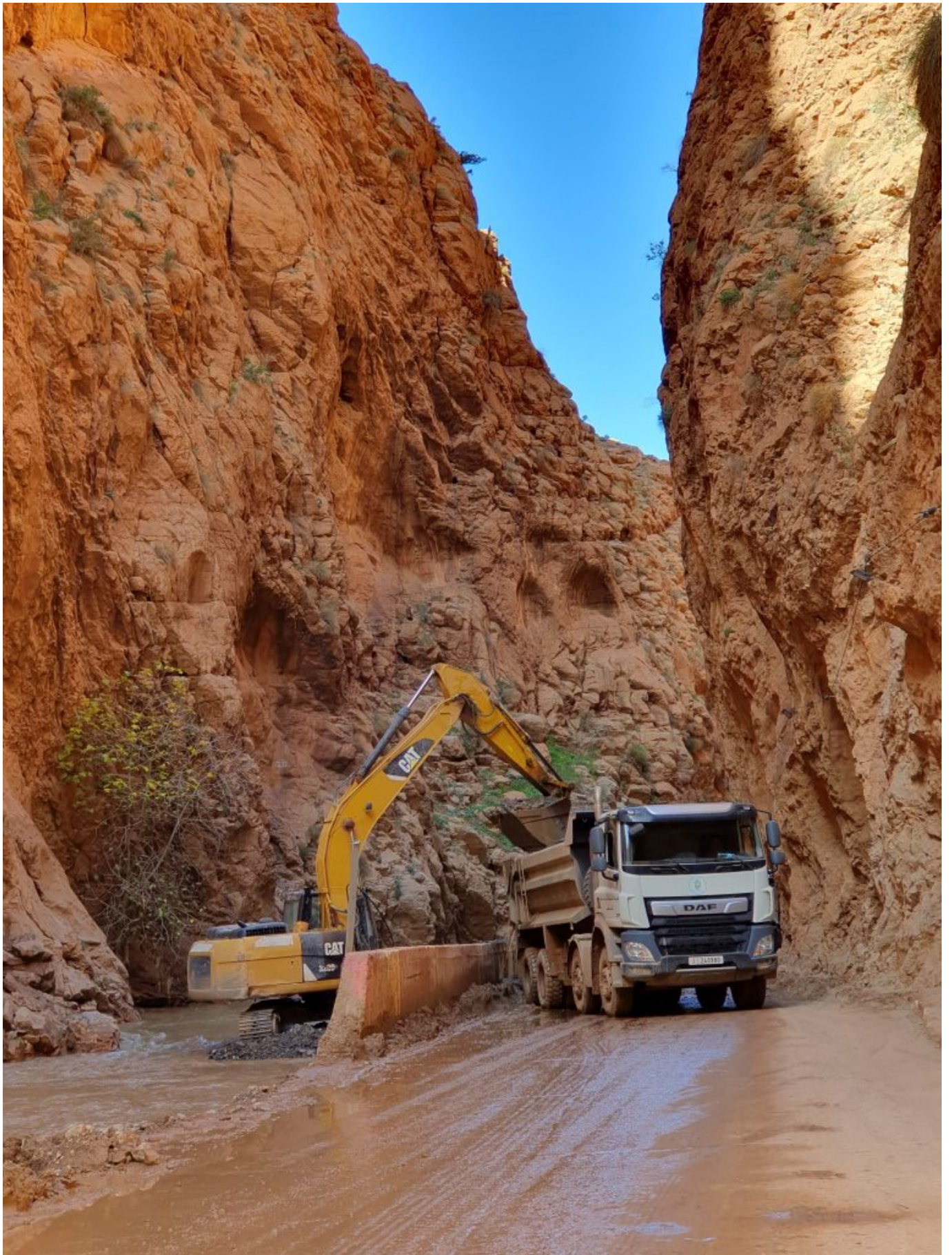
Fluß wird freigebagert. Zwischen 2 LKW's kommen wir durch
